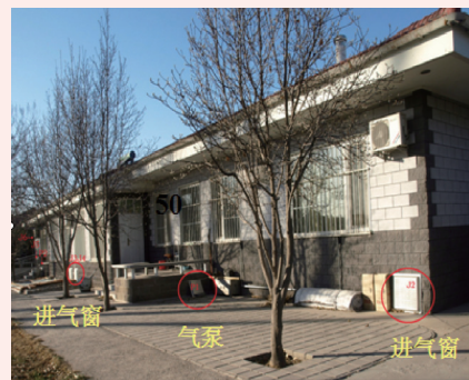
图2 房地地基处的进气窗和气泵
