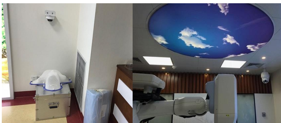
图 4-5 射波刀机房通风口
