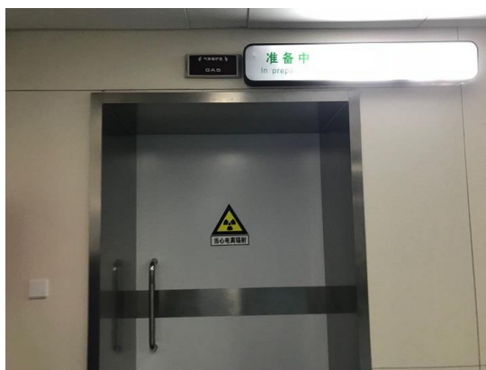
图 4-2 射频刀机房外工作状态指示灯及电离辐射警告标志
